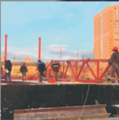
СТРОИТЕЛЬСТВО ЦЕНТРА ЕДИНОБОРСТВ
