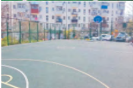
Реконструкция спортплощадки в ул. Леженина, 90, стоимость работ - 893,4 тыс рублей
