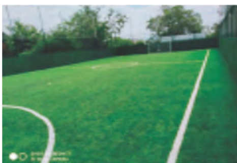
Реконструкция спортплощадки в пер. Краснознаменном, 6, стоимость работ - 1524,3 тыс рублей
