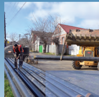
РЕМОНТ СЕТЕЙ В ГОРОДЕ
