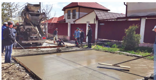
БЕТОНИРОВАНИЕ МЕТОДОМ «НАРОДНОЙ СТРОЙКИ»
