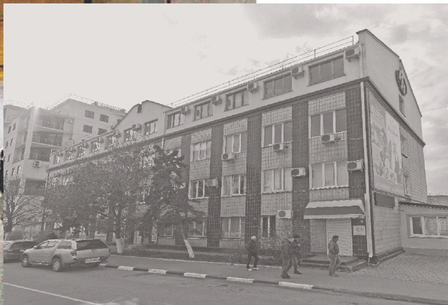
Здание управления хладокомбината г. Новороссийска на ул. Мира. Начало XXI в.
